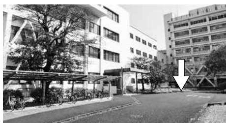
図3 現在講義・研究棟前道路と事故現場
