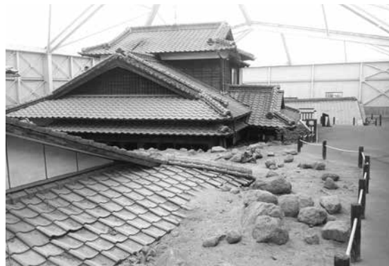
写真2 土石流被災家屋
